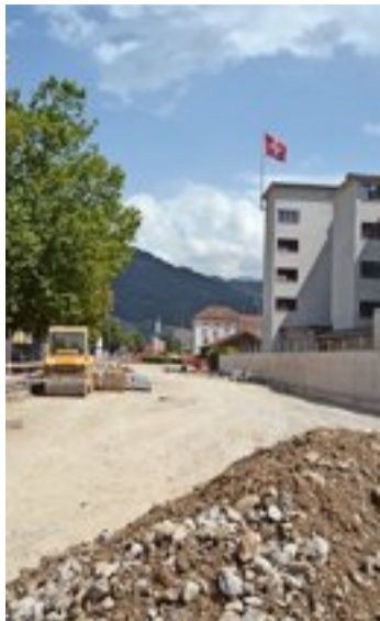
Die Allmendstrasse wird derzeit richtig «umgepflügt».
