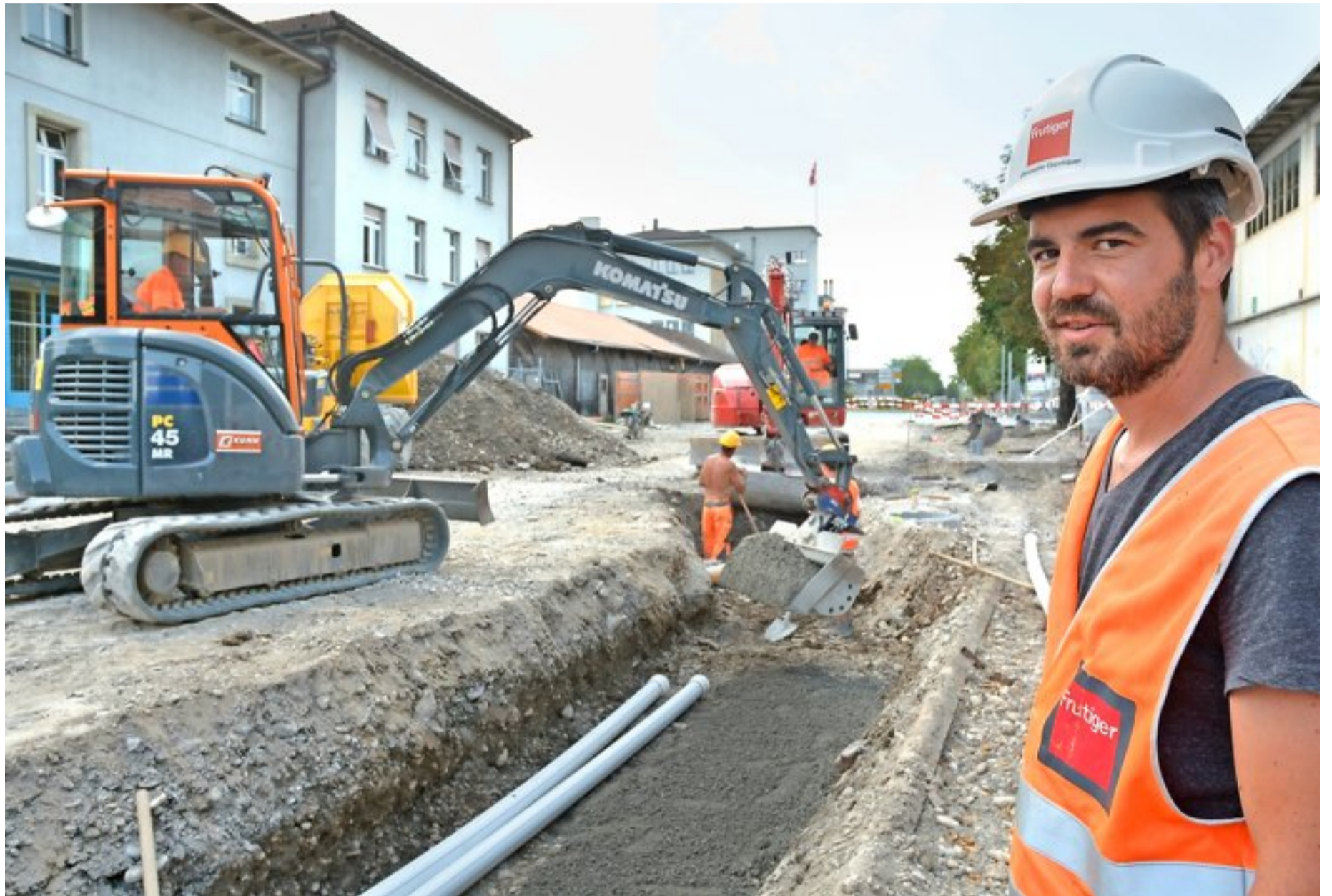
Bauführer Christophe Oelliguer und sein Team erleben an der Allmendstrasse eine intensive Bauphase. Er ist zuversichtlich, dass der Verkehr ab 15. August wieder rollt.
